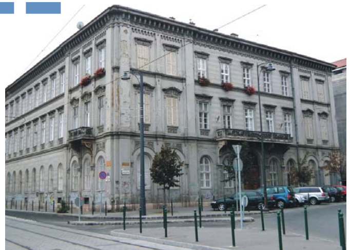
Homlokzati részét állkonzolos főpárkány veszi körbe (A képek a szerző felvételei)
