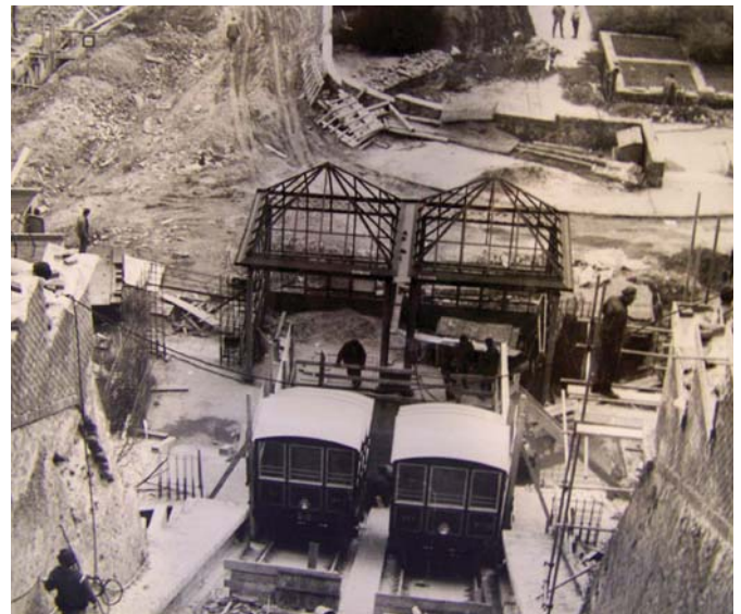
A budavári Sikló újjáépítésének kezdete (1984)
