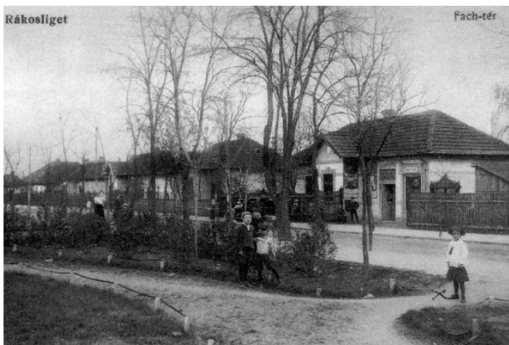
Rákosliget – a Fach tér kiépítése után
