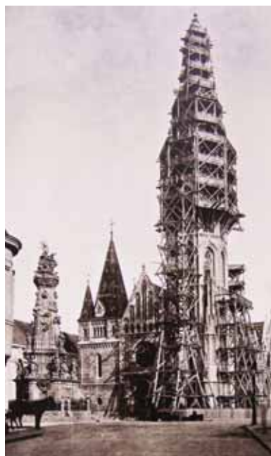
A Mátyás-templom helyreállítás közben (1893)
