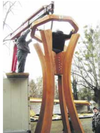
A harangláb felső koszorújának szerelése
