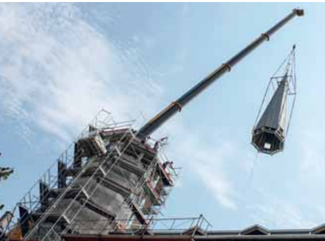
A torony záró elemének beemelése
