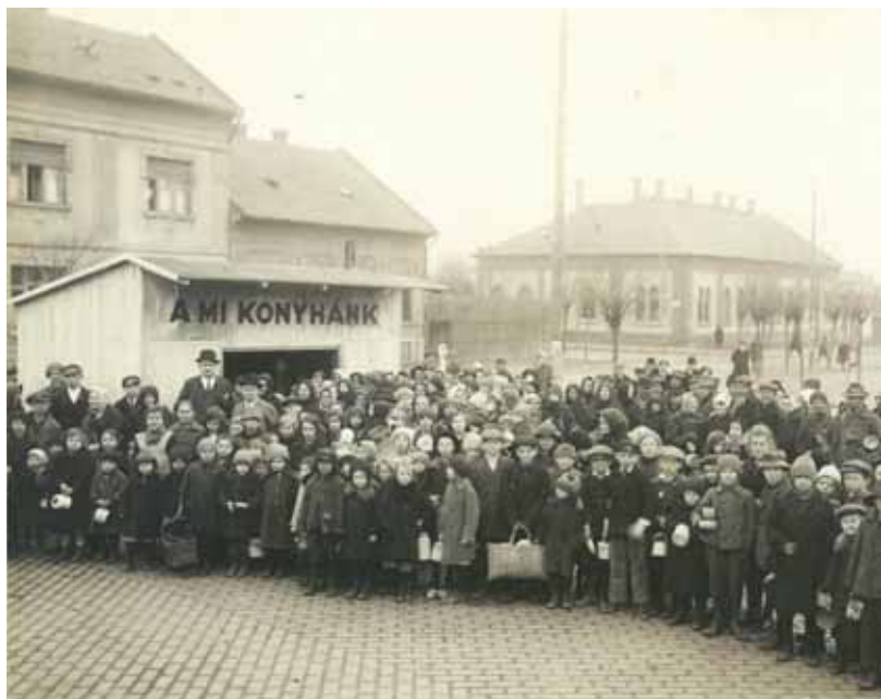
A Mi konyhánk első „épülete”
